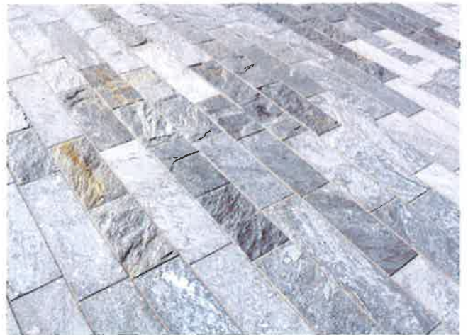
Detail des Dorfplatz-Plattenbelags aus SAN BERNARDINO SILBER in drei unterschiedlichen Bearbeitungsarten: gestrahlt, geflammt und gespalten
