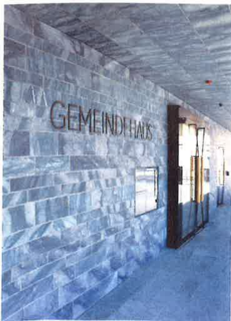
175 t BLAUSEE-KIESELKALK in Form massiver Mauersteine sind für die Fassade der Gemeindehaus-Erweiterung in Meilen verbaut worden. Deutlich erkennbar die geschliffenen Partien im Bereich der Fensterausschnitte (oberes Bild) und im Eingangsbereich (unten). Fotos: R. Stadler
